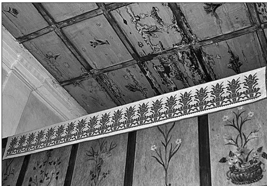
Festett kazetták károsodásai beázást követően a medeséri templomban. A szerző felv.
